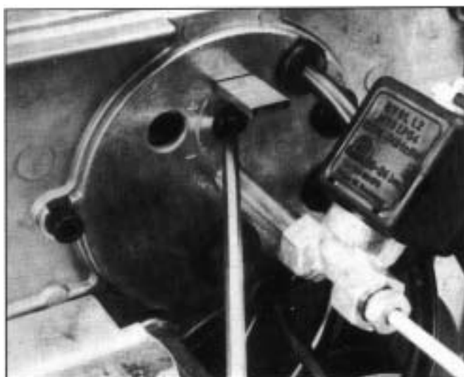
zdj.4 Wtórna regulacja powietrza (regulacja płytki spiętrzającej)
